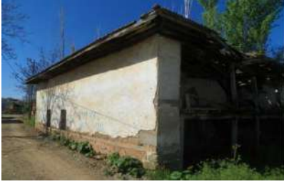
Resim. 13 Tımarlı Köyü Cami Doğu Cephesi
