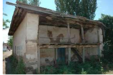
Resim.12 Tımarlı Köyü Cami Giriş Kısım
