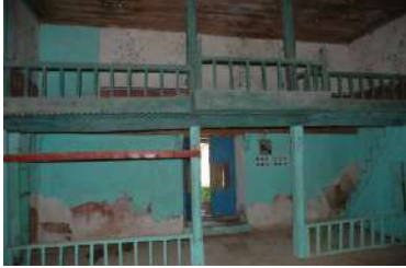
Resim.19 Tımarlı Köyü Cami Giriş Kısım
